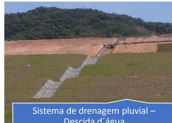
Sistema de drenagem pluvial –
