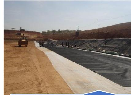
Instalação de manta PEAD sobre o GCL.
