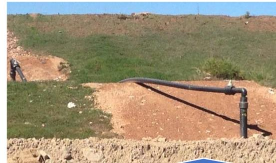
Exemplo de Sistema de Drenagem de Gases
