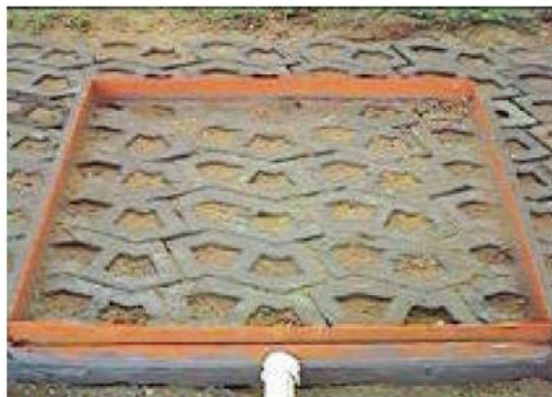
Figura 18. Blocos de concreto vazados (Araújo Tucci, Goldenfun, 2000)
