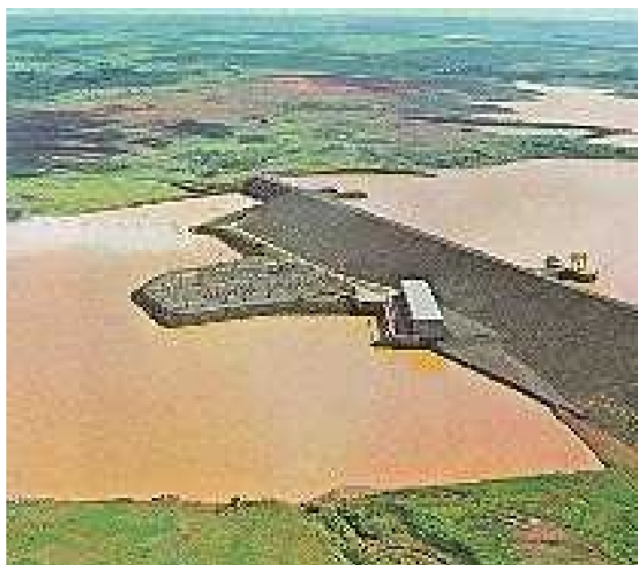
Foto I.4.3.e. UHE Escola de Engenharia Mackenzie (Capivara). Foto: CESP (1999).
