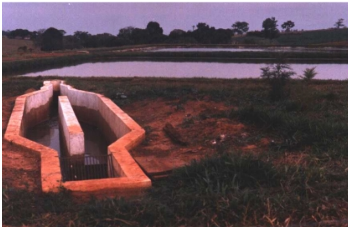
Foto I.4.5.c. Vista de ETE (lagoa de estabilização) em Nantes, UGRHI - 22.
