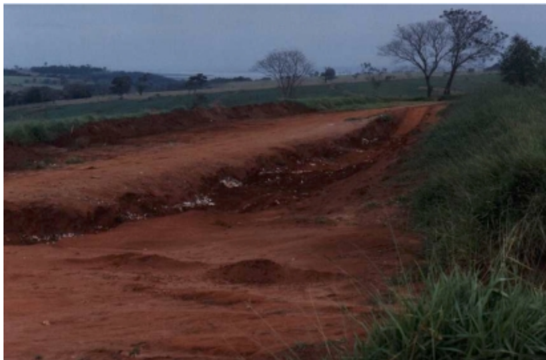
Foto I.4.5.d. Disposição de resíduos em vala, no município de Nantes, UGRHI - 22.
