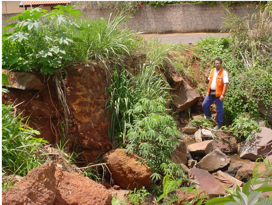
Figura 6.11 - Boçoroca no município de Três Fronteiras.
