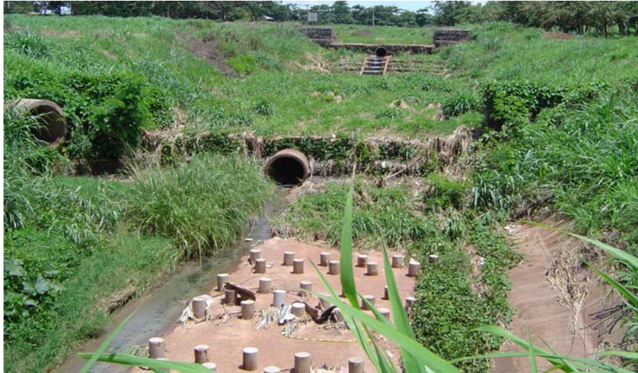
Figura 6.14 - Contenção da erosão por meio de obras.
