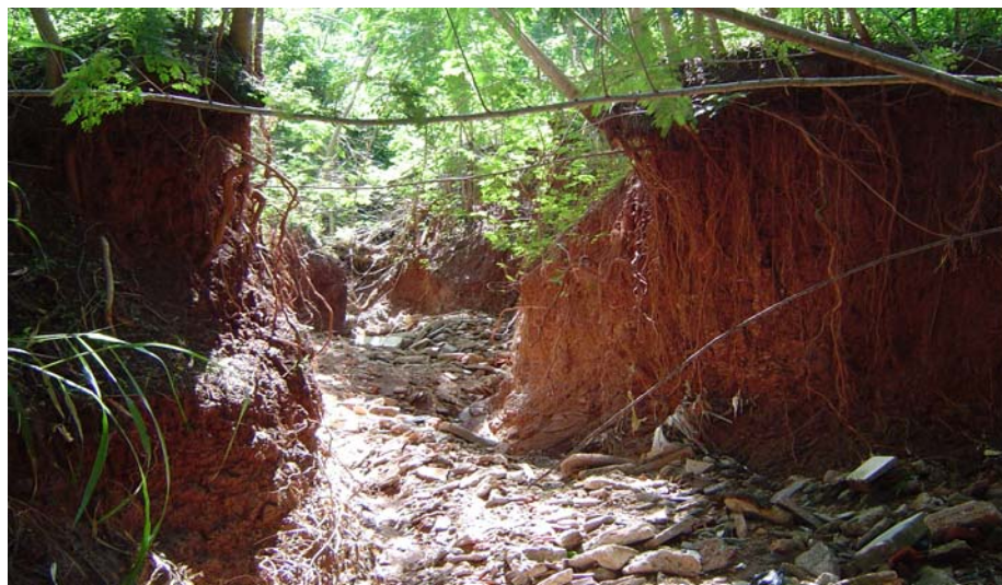
Figura 6.13 - Presença de cascalhos e galhos no interior da ravina.
