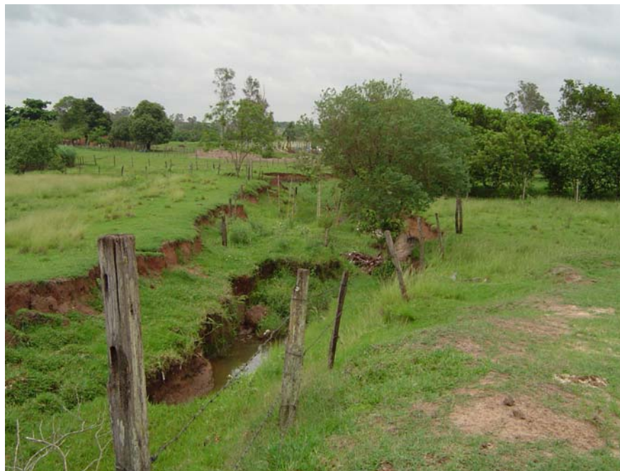
Figura 6.6 - Erosão com abatimentos dos taludes.
