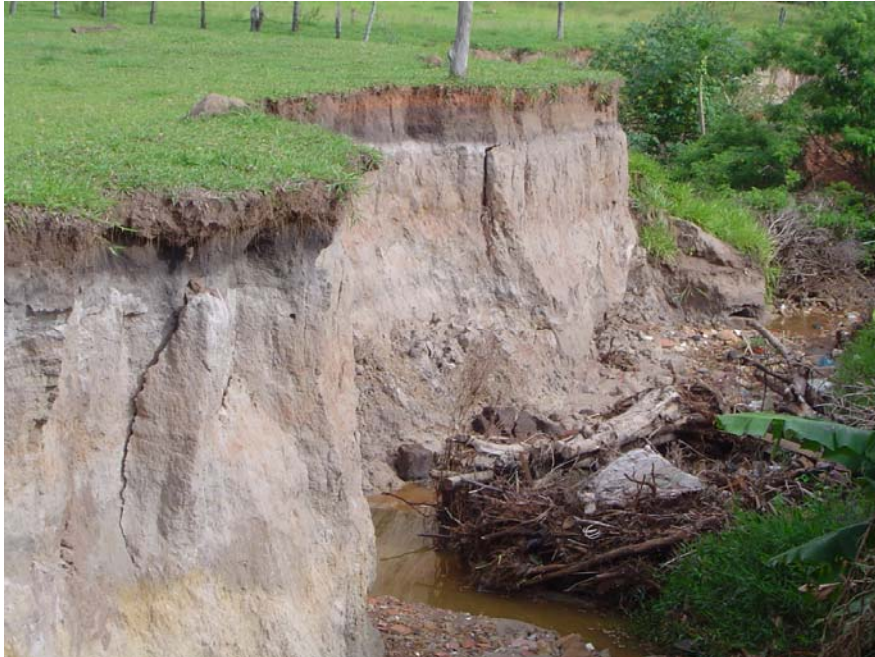
Figura 6.9 - Processo erosivo preenchido por entulhos e galhos na rua Antônio Miranda em Auriflama.
