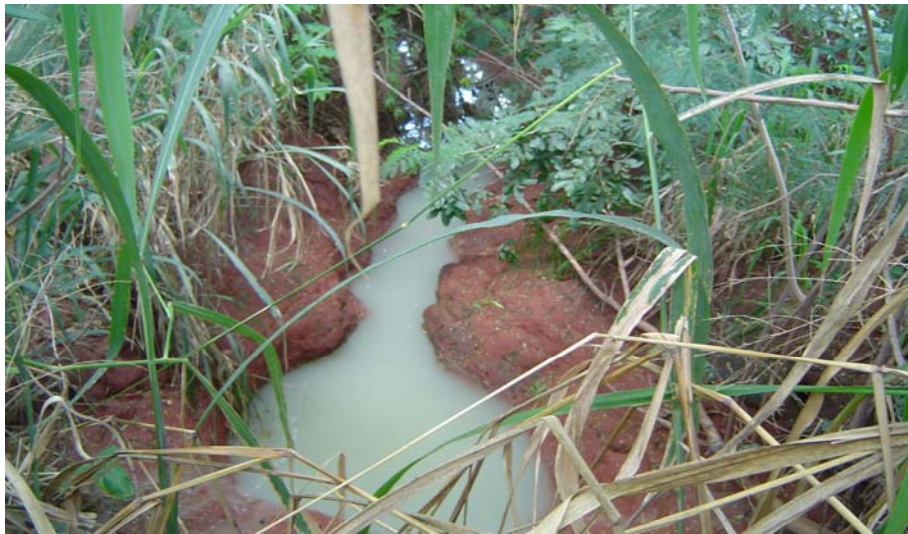
Figura 6.15 - Contenção da erosão por meio de obras.
