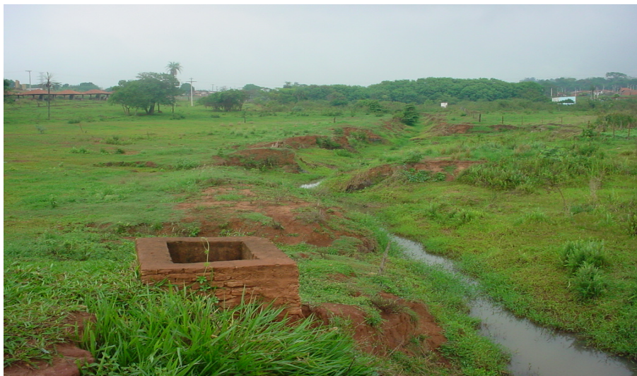
Figura 6.16 - Contenção da erosão por meio de obras.
