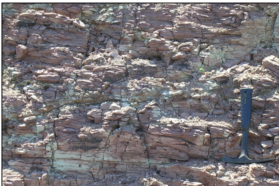
Figura 35 - Detalhe do argilito Corumbataí, vermelho-arroxeadado com manchas esverdeadas, destacando o pastilhamento que é típico desta entidade estratigráfica.
