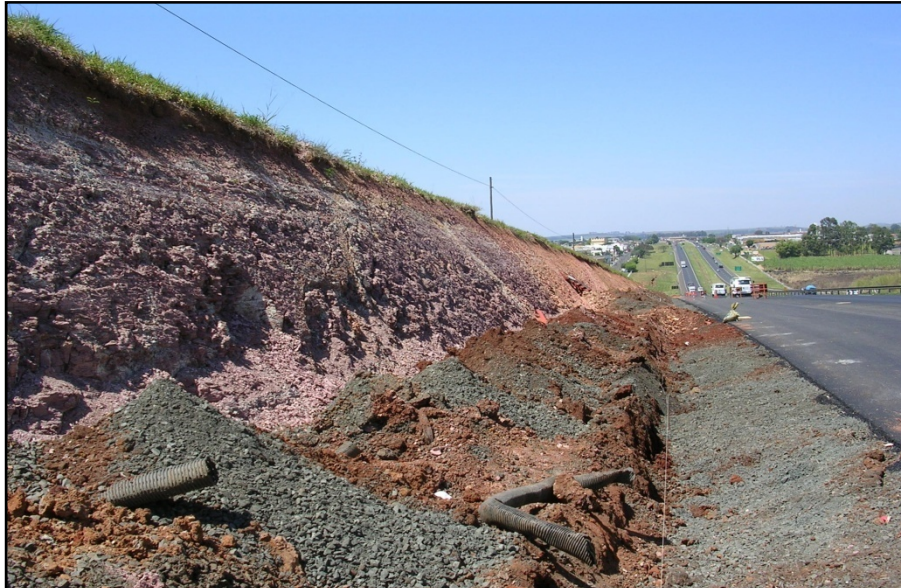
Figura 36 - Corte na rodovia Anhanguera, com obras em execução, com vista mais geral dos sedimentos argilosos da Formação Corumbataí, com coloração arroxeada, vendo-se ao fundo construções das imediações da cidade de Leme.
