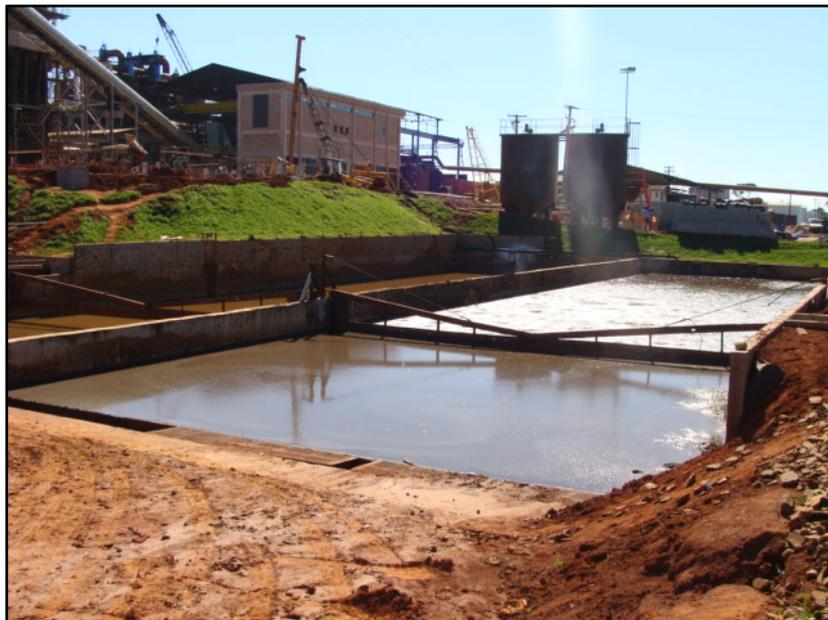
Figura 96 - Caixas de decantação da água de lavagem de cana.
