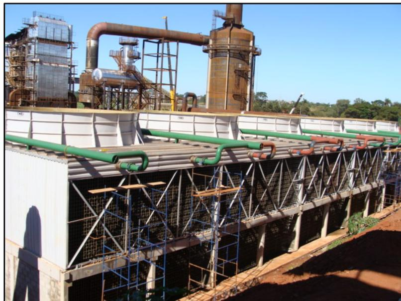
Figura 97 - Sistema de resfriamento por aspersão das águas da fabricação
