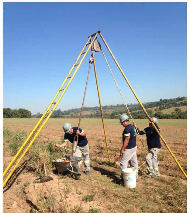
Instalação de Poço de Monitoramento
