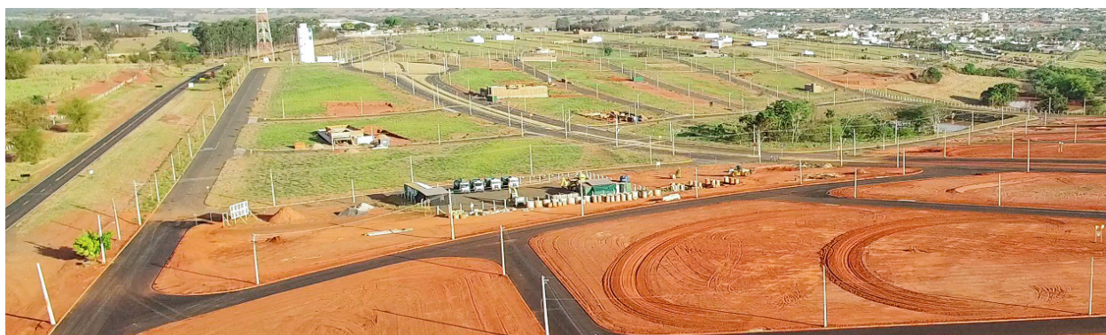
Canteiro de Obras
